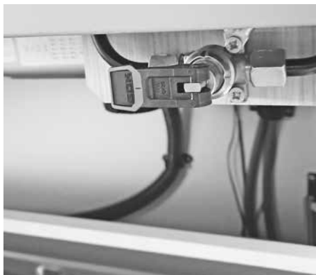
Valvola di intercettazione del blocco cucina
