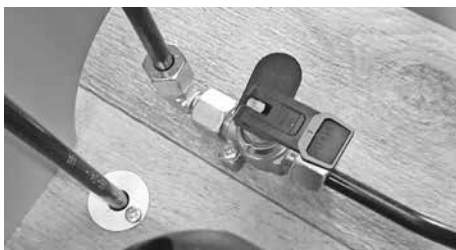
Valvola di intercettazione del riscaldamento
