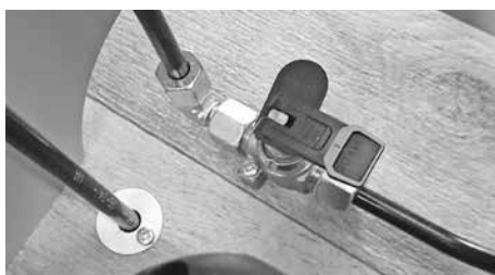
Llave de paso para la calefacción
